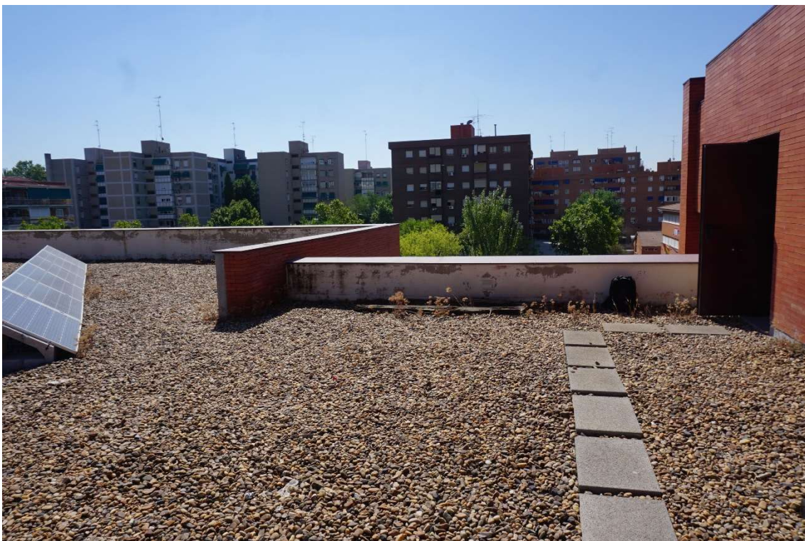
CUBIERTA. AFLORAMIENTO DE VEGETACIÓN.
