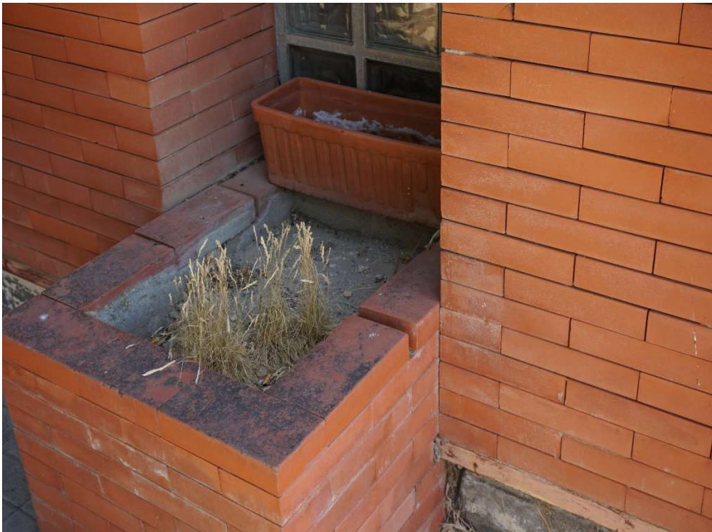
FACHADA TRASERA. PLANTA BAJA. ROTURA DE VASOS DE JARDINERA.
