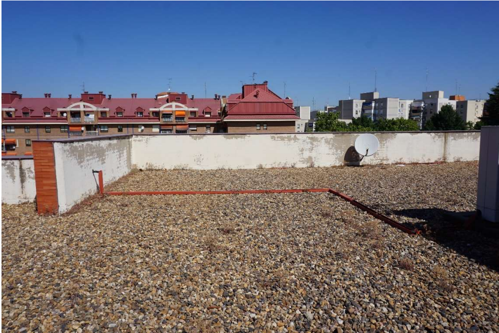
PETOS DE CUBIERTA. DESPRENDIMIENTO DE PINTURA PROTECTORA.
