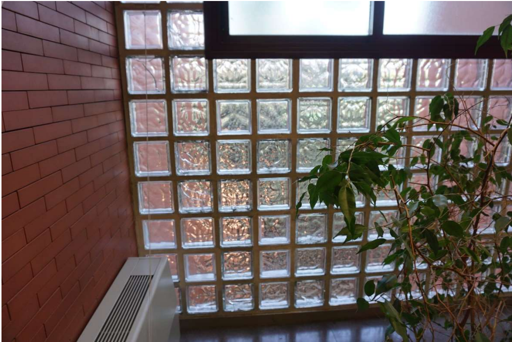
FACHADA TRASERA. PLANTA PRIMERA. ÁREA DE ROTURA DE 40% DE PIEZAS DE VIDRIO.
